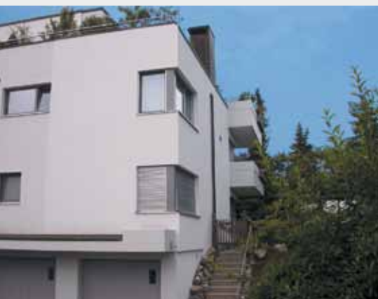
Ergebnis nach der Sanierung
