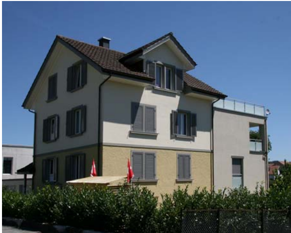
© Foto: Fassadensanierung Max Schweizer AG, Zürich
