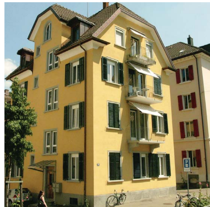
Problemlösung Fassade: Erfolgreich umgesetzt mit «schweizer combi».
